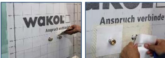
**\*Passo 8 //** Aplicar WAKOL MS 552 Adesivo para PVC e borracha na área das aberturas de instalação na parede e deixar secar ao ar durante, pelo menos, 20 minutos.
