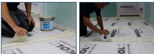
**\*Passo 7 //** Aplicar WAKOL MS 552 Adesivo para PVC e borracha na área marcada à esquerda e à direita do encosto das faixas e deixar secar ao ar durante, pelo menos, 20 minutos.
