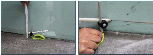
**\*Passo 1 //** Marcação das áreas para a aplicação de adesivo na parede e no piso a 6 cm de altura e largura.
