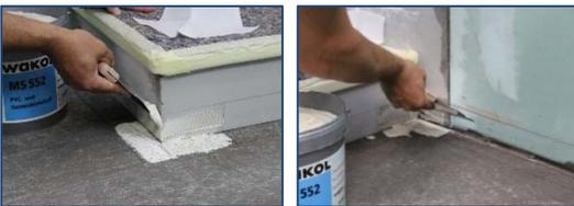
**\*Passo 2 //** Aplicar WAKOL MS 552 Adesivo para PVC e borracha com a espátula dentada TKB B1 na área dos cantos internos e externos.
