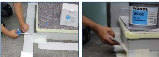
**\*Passo 3 //** Cortar WAKOL AS 152 Fita seladora ao comprimento; sobrepor os cantos de vedação aprox. 5 cm.
